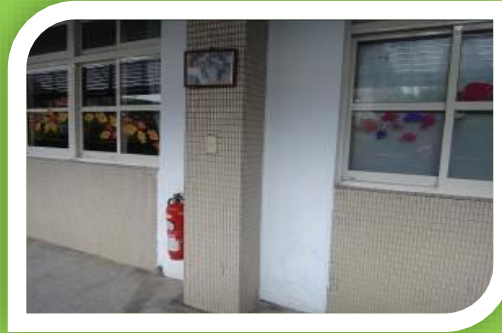
耐震詳評及結構補強
