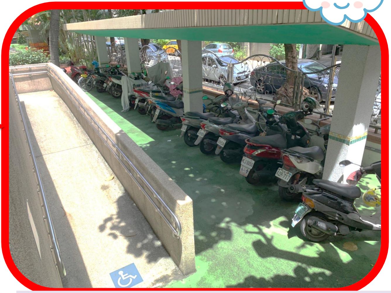
【機車棚、無障礙坡道】 請勿在此遊玩
